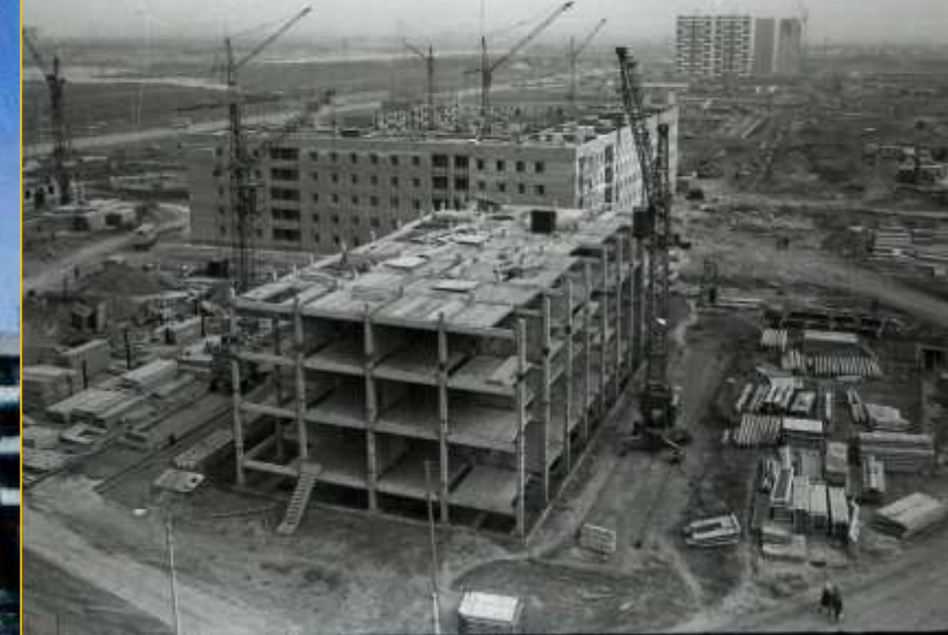
Строительство дома быта "Радуга"
